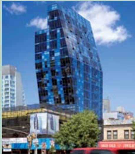
La «Blue Tower» © BTua BERNARD TSCHUMI urbanistes ARCHITECTES
