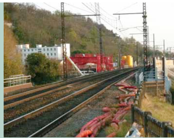
Travaux sur le secteur Victor Hugo
