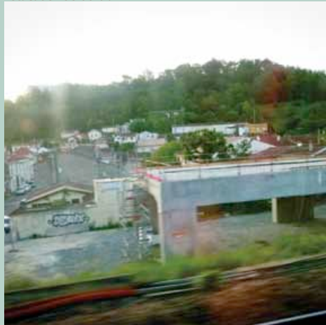
Estacade vue du train
