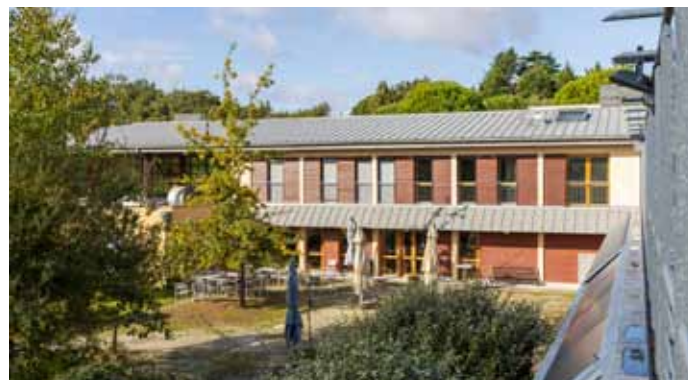
Foyer de vie du Cypressat
